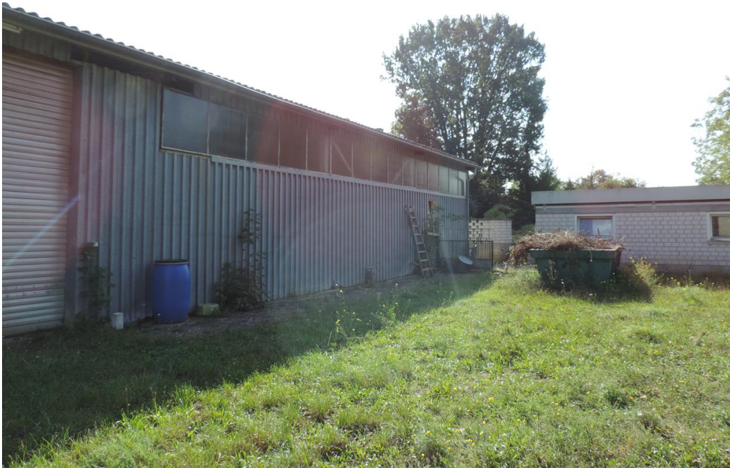
Bild 03: Blick auf die Westseite der Lagerhalle und die vorgelagerte Grünfläche sowie das angrenzende Gebäude mit Hundezwinger und Jagdraum
