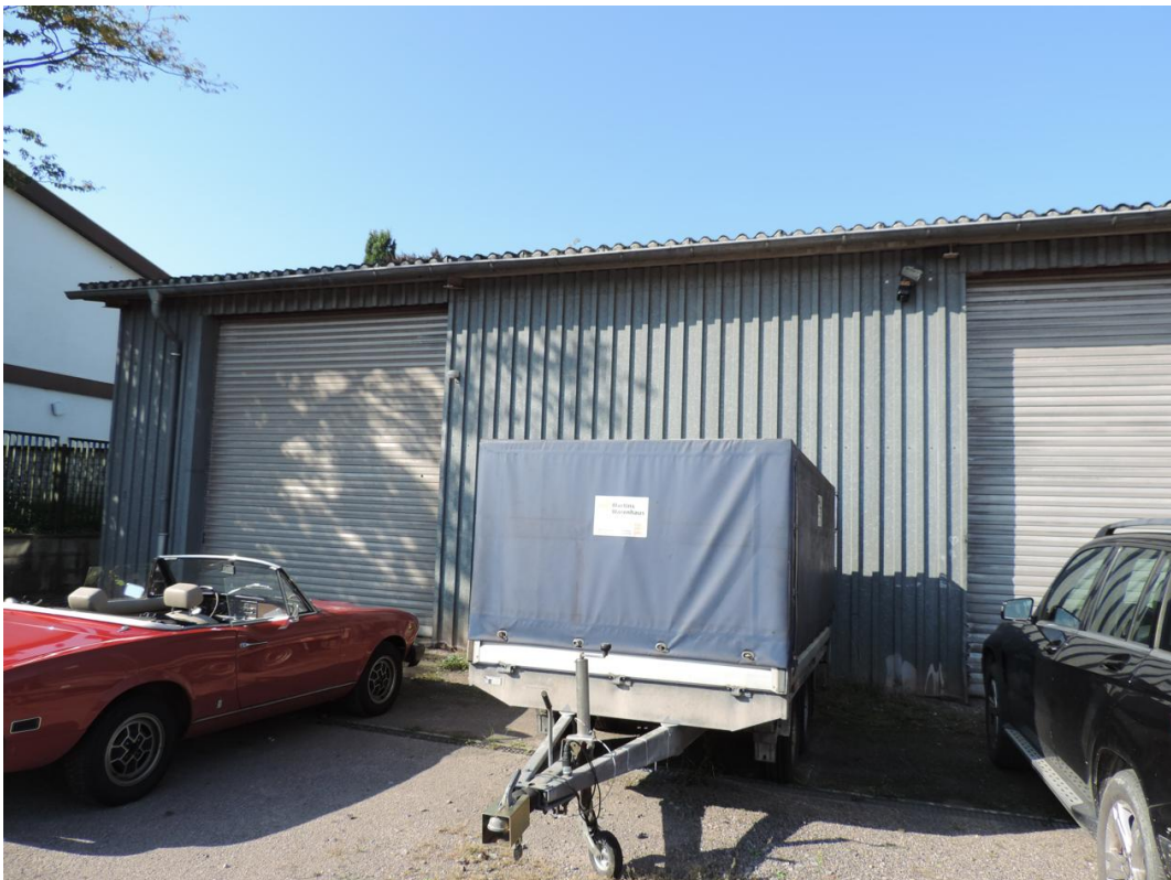
Bild 02: Weiterer Blick auf die Lagerhalle
