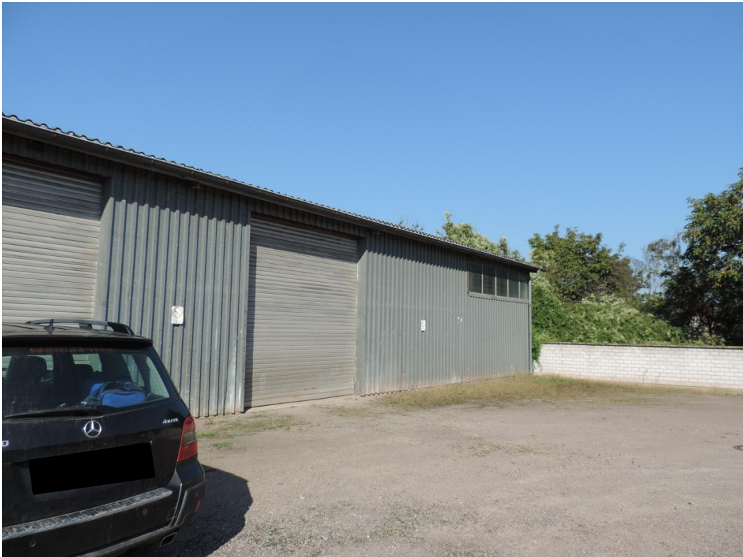
Bild 01: Blick auf die Lagerhalle im Norden des Plangebietes
