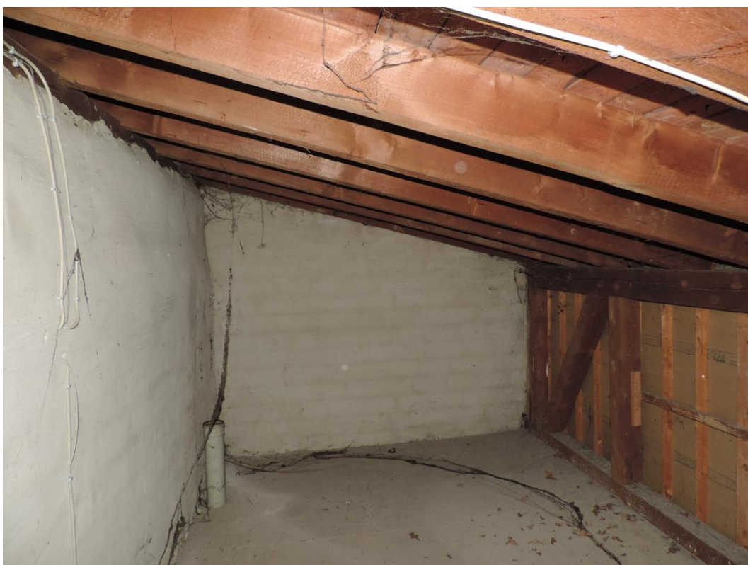
Bild 18: Blick in den Dachstuhl der Villa
