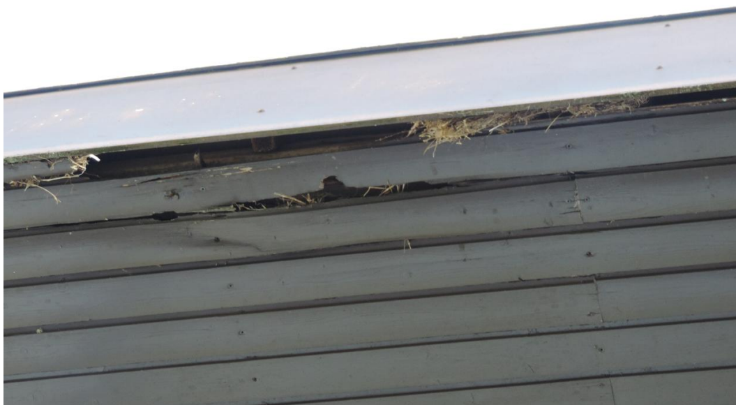
Bild 13. Spalten mit Nistmaterial in der Holzverkleidung des Daches der Villa
