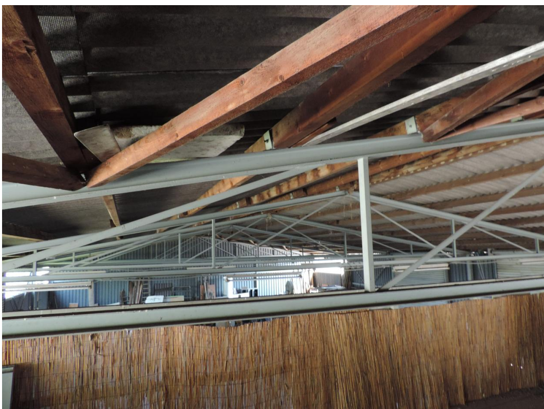
Bild 17: Blick in die Lagerhalle
