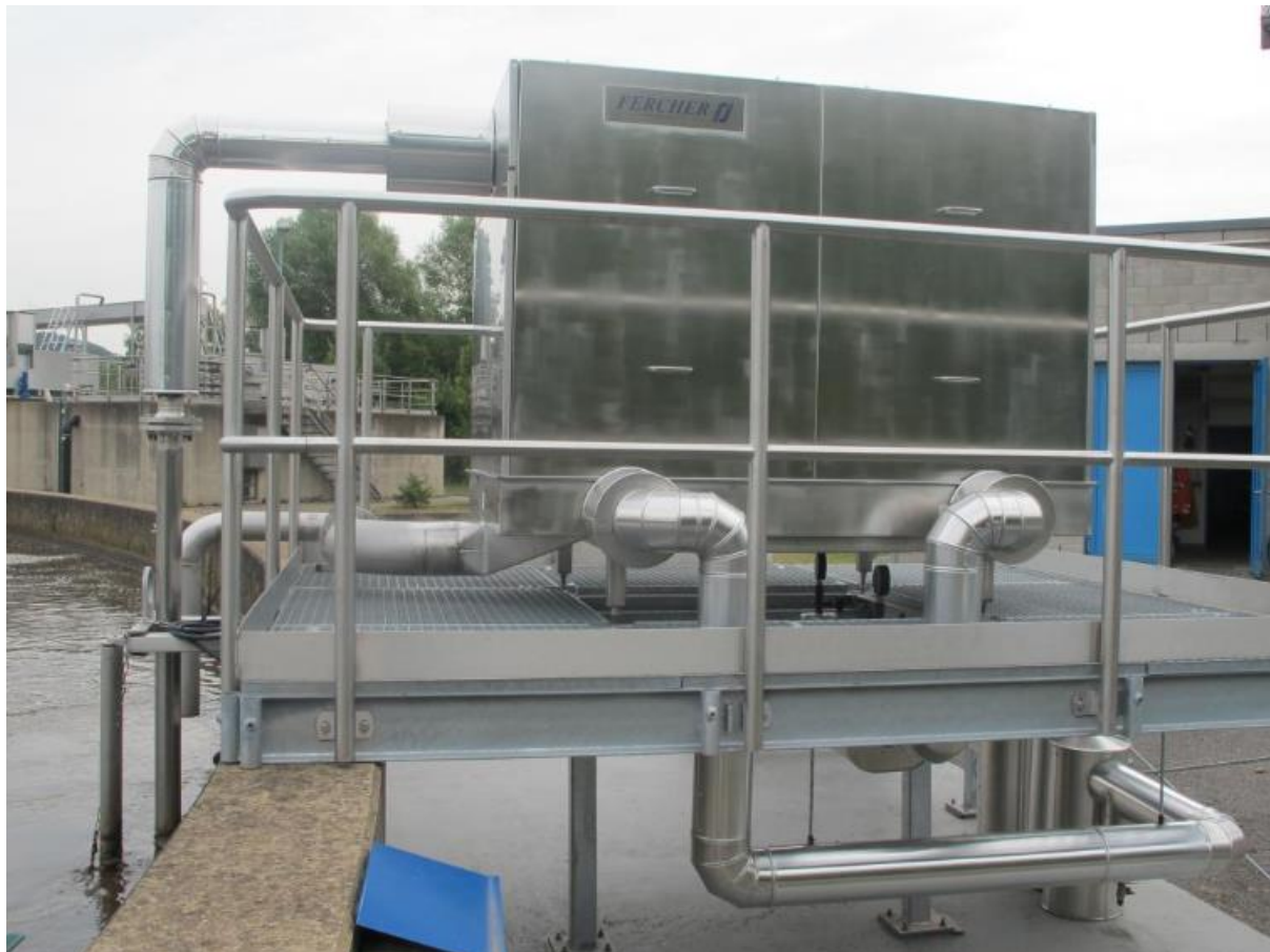
Abbildung 91: Abwasserwärmetauscher FERCHER FB-6/S-1-1 in einem Klärwerk (FERCHER GmbH, 2025)
