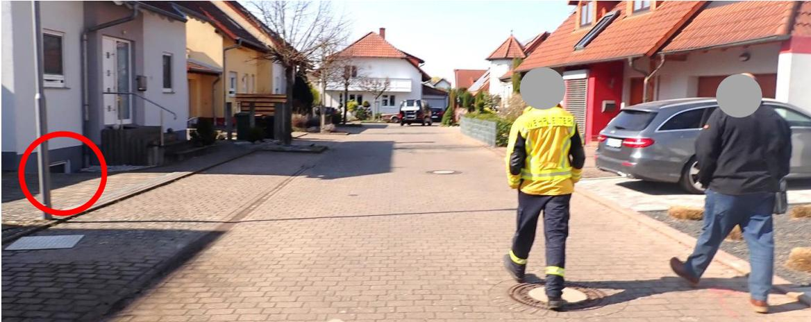
Abb. 12: Erschließungsstraße mit niveaugleichem Ausbau und angrenzender Bebauung mit Kellern und tiefliegenden Fenstern und Türen (2022)
