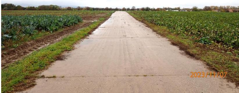
Abb. 23: Aufgewachsene Bankette entlang des Betonwegs
