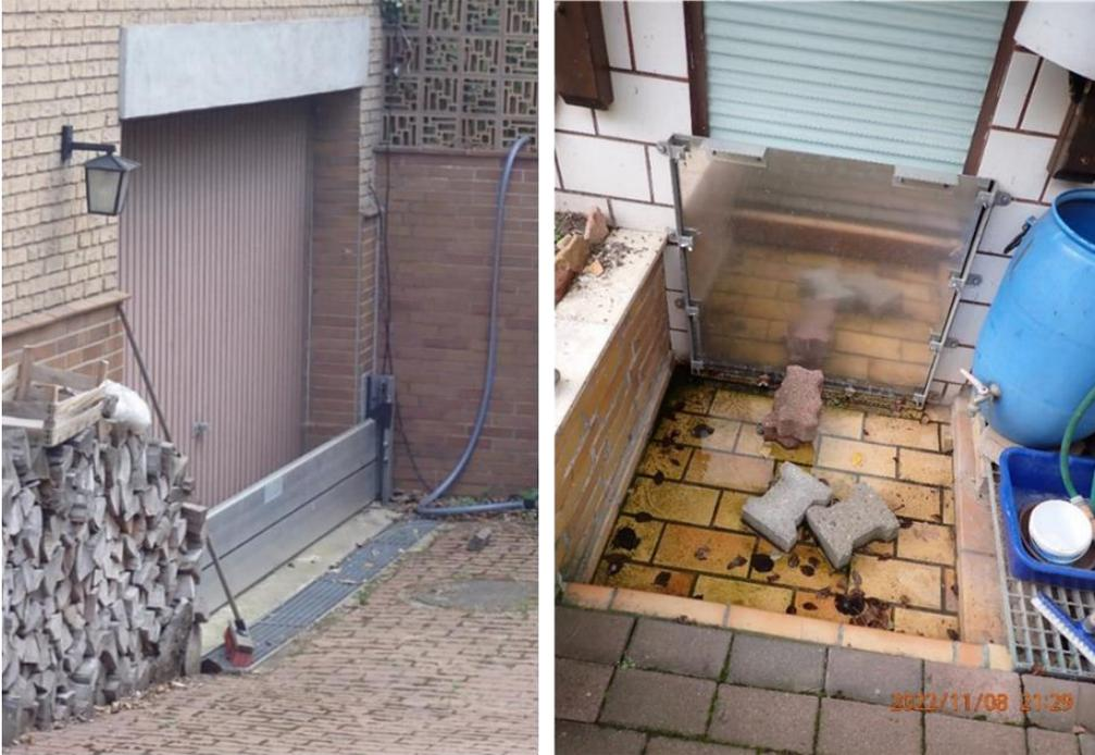
Abb. 15: Dammbalkenverschluss (links) und Schott (rechts)
