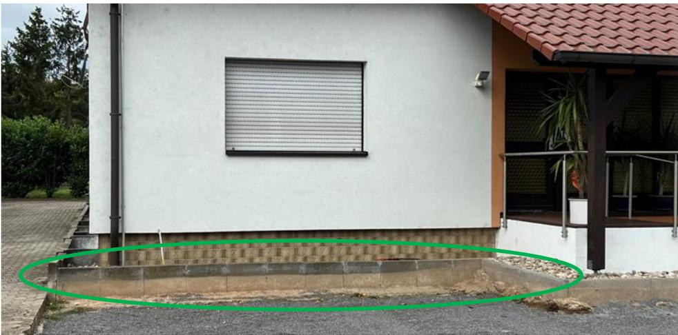
Abb. 88: Beispiele für die Sicherung von niveaugleichen Lichtschächten
