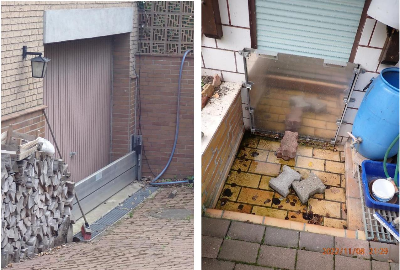
Abb. 90: Dammbalkenverschluss (links) und Schott (rechts)
