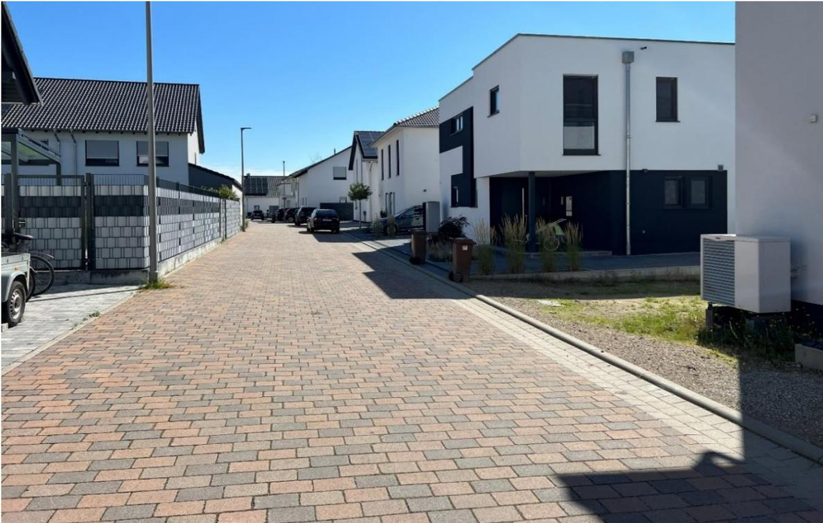
*Abb. 58: Beispiel für oberflächlich entwässerte Straße im Baugebiet „Im Alten Sägewerk“ und niveaugleiche überflutungsgefährdete Bebauung*
