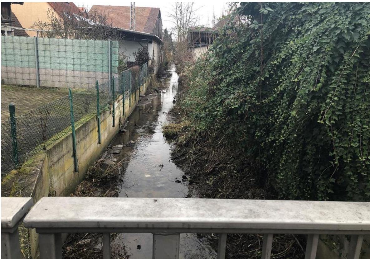
Abb. 40: Beispiel für eingengten Fließquerschnitt im Hofgraben
