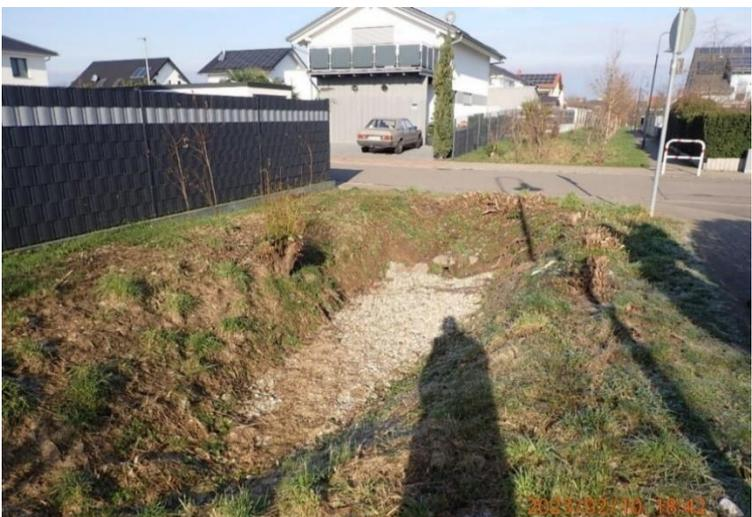
*Abb. 56: Beispiel für unterhaltungsintensive Straßenquerung in einer Versickerungsmulde*
