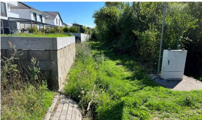
*Abb. 94: Beispiel für einen hochstehenden Stromverteilerkasten (Pegel Hofgraben) im überflutungsgefährdeten Bereich*
