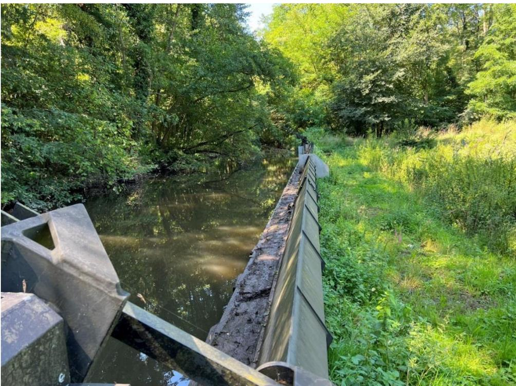
Abb. 24: Wehre am Abschlag von Hochwasser aus der Queich in den Flutgraben zur Druslach
