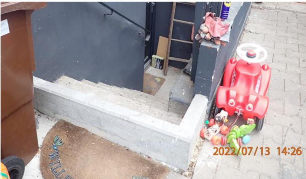
Abb. 89: Beispiel für die Sicherung eines außenliegenden Kellerzuganges
