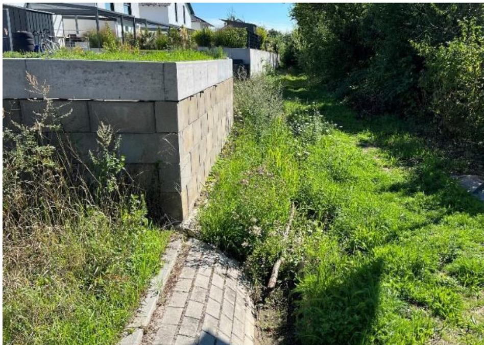
Abb. 57: Fehlende Versickerungsmulde im Neubaugebiet „Im Alten Sägewerk“ am Hofgraben, 2022
