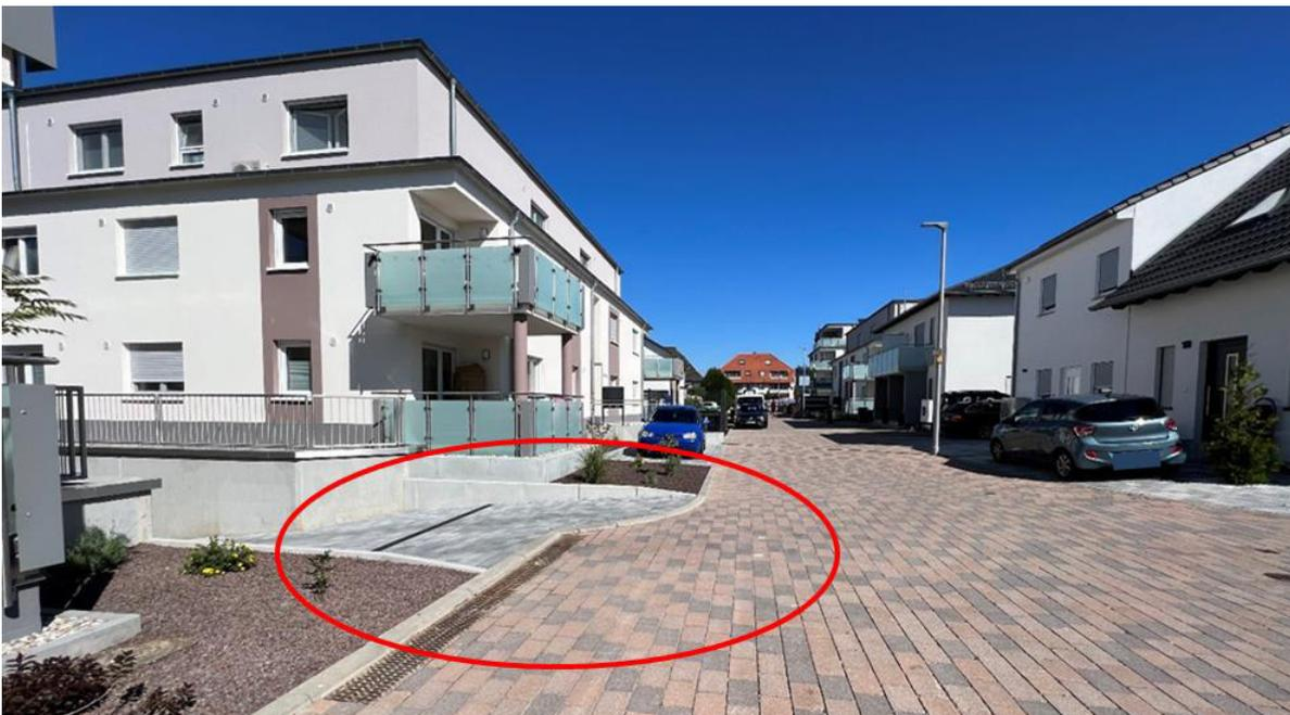
*Abb. 59: Zufahrt zur Tiefgarage mit kaum ausgebildeter Schwelle zur Wasserführung zwischen Straße und Privatgrundstück*
