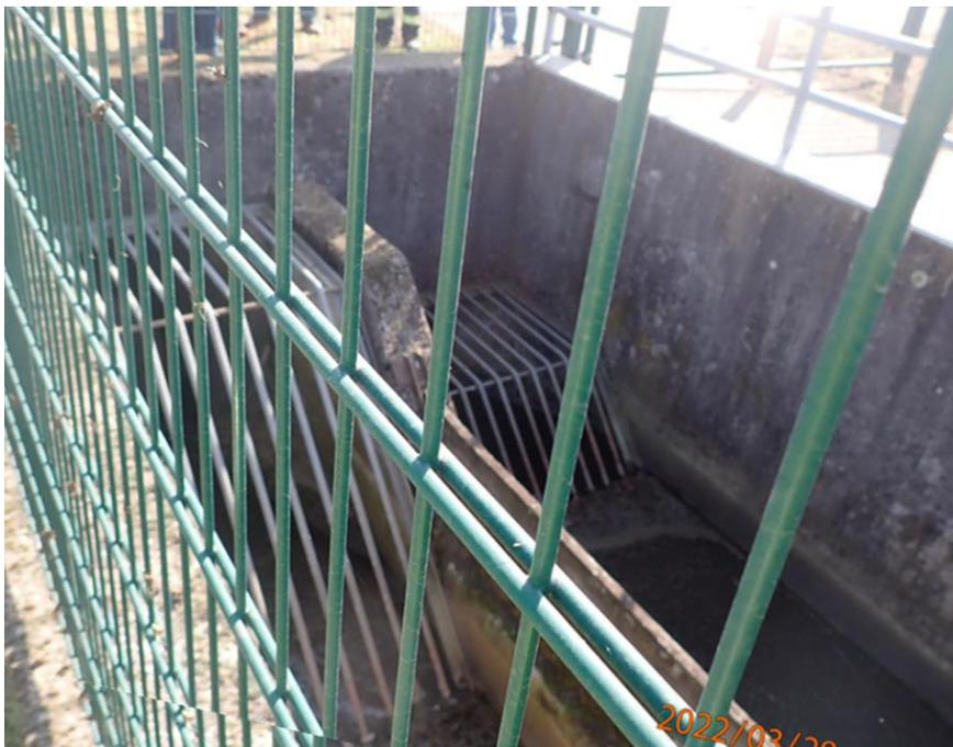
Abb. 34: Zulauf zu den Dükerleitungen zur Unterquerung der Bundesstraße B 9
