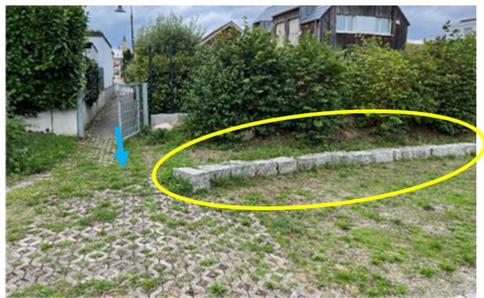
Abb. 62: Abschüssige Straße und Fußweg als Beispiel für einen Notabflussweg zu einer zentralen Sickerfläche mit Schwelle (gelb) als Rückhalt
