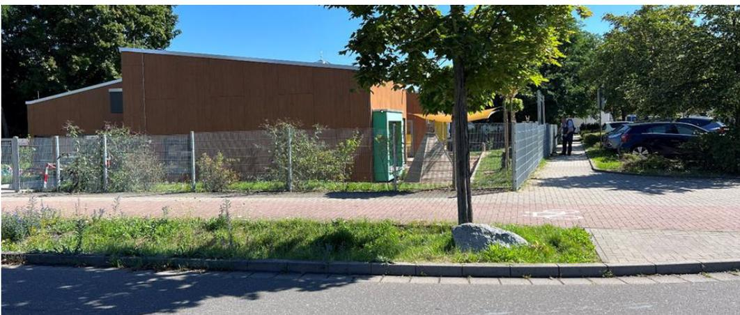
Abb. 52: Kindertagesstätte unter Geländeneiveau mit Versickerungsmulde für Straßenwasser im Vordergrund
