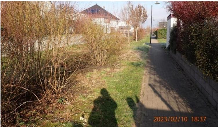
*Abb. 55: Beispiele für unterhaltungsintensive Versickerungsmulden*
