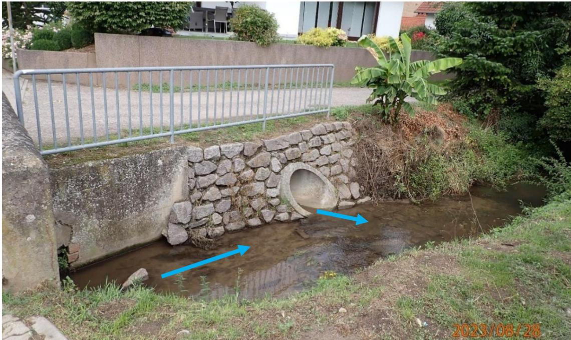
Abb. 49: Hofgraben unterhalb der Röderstraße mit einmündender Regenentlastungsleitung
