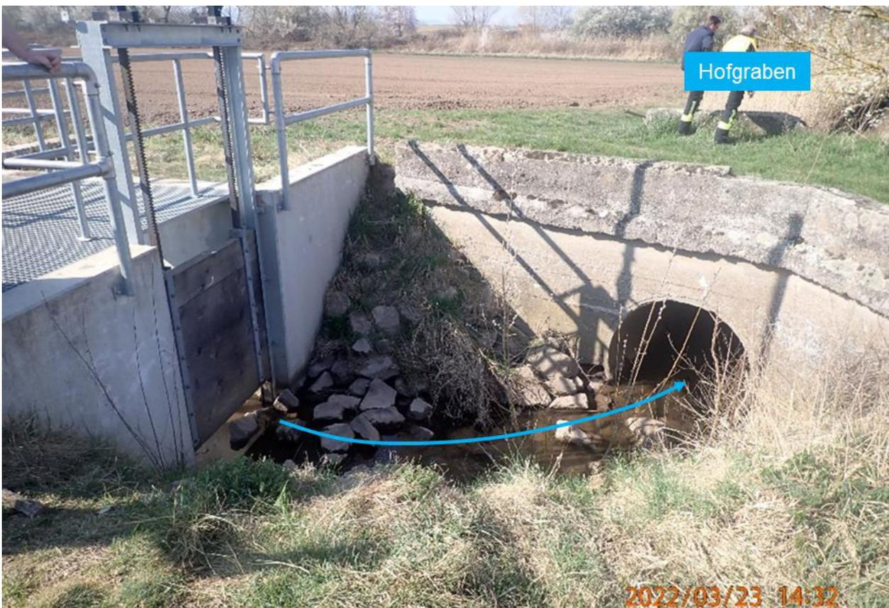
Abb. 8: Trennbauwerk zum Hochwasserschutz von Lustadt
