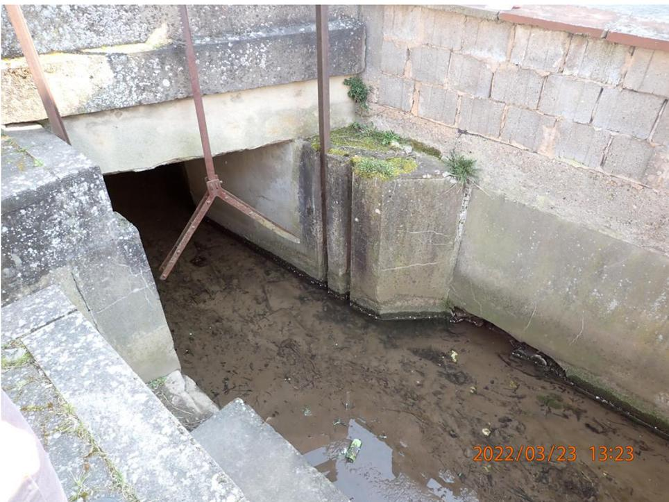
Abb. 83: Verzichtbares Gestänge einer alten Staueinrichtung
