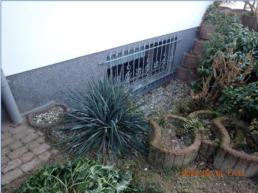
Abb. 21: Beispiel für überflutungsgefährdete Bauweise durch Untergeschoss unter Straßenniveau
