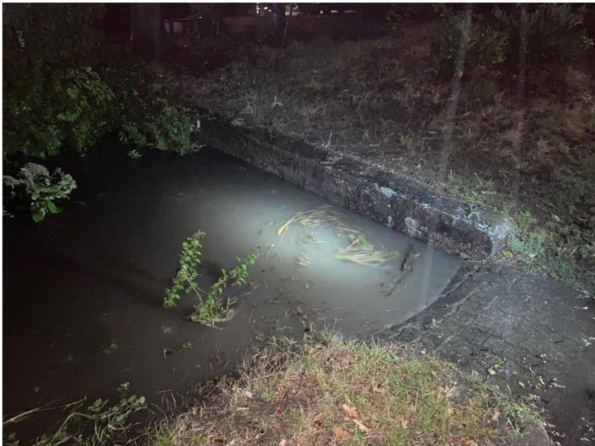
*Abb. 90: Einstau der Verrohrung Raiffeisenstraße bei Starkregen 06/2022,
