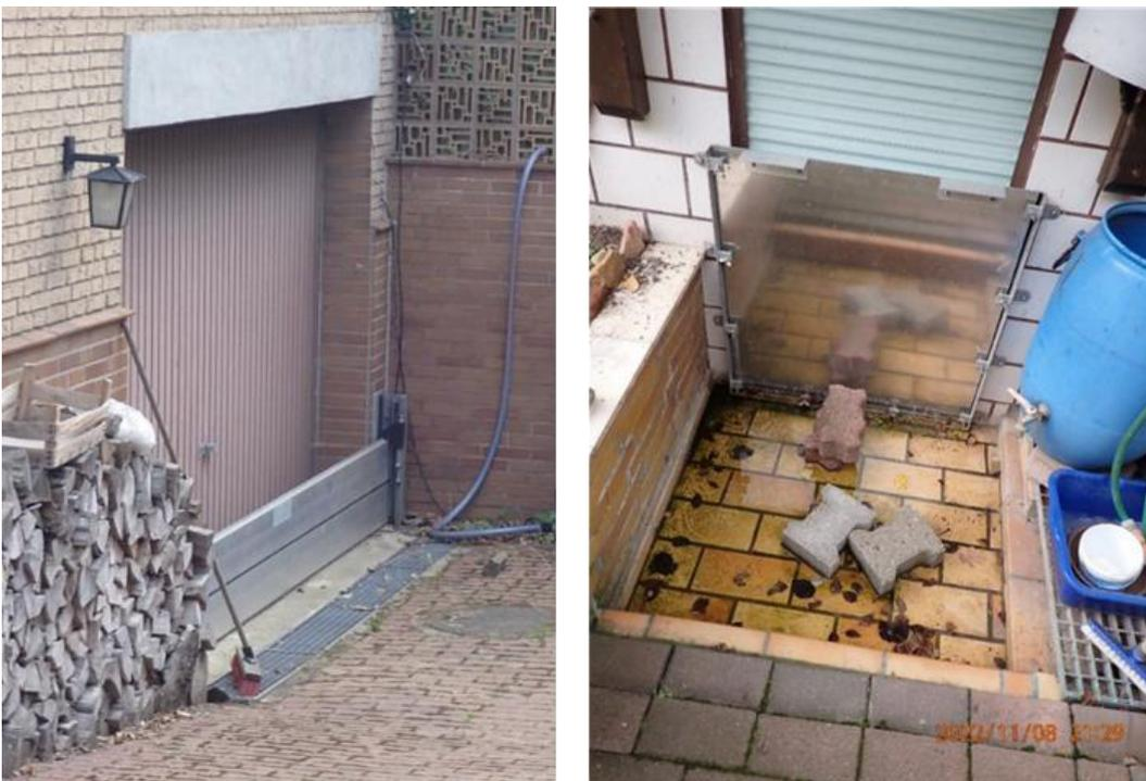
Abb. 24: Dammbalkenverschluss (links) und Schott (rechts)
