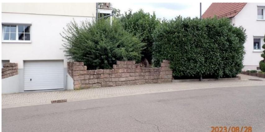
Abb. 20: Beispiele für überflutungsfördernde Bauweise durch abschüssige Garagenzufahrten
