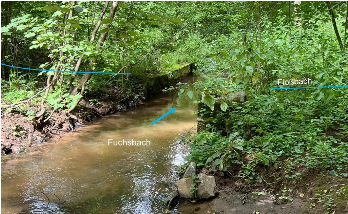
Abb. 5: Hochstadter Heber: Trog zur Querung des Fuchsbachs über den Floßbach, 08/2023
