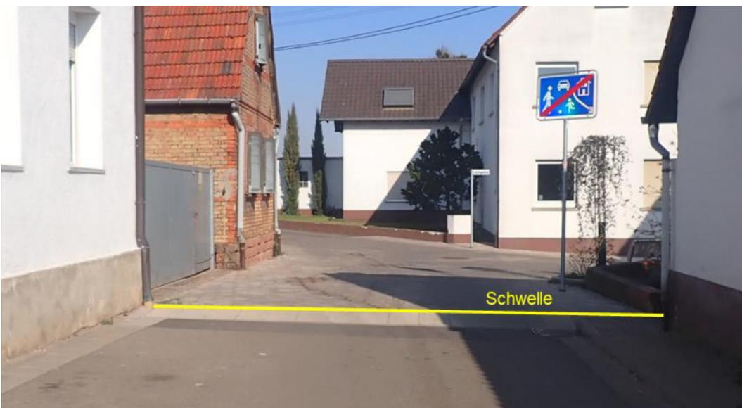
Abb. 97: Schwellen im Amselweg und in der Straße „Am Sträßel“ zur Aufnahme von Oberflächenabfluss in die Kanalisation
