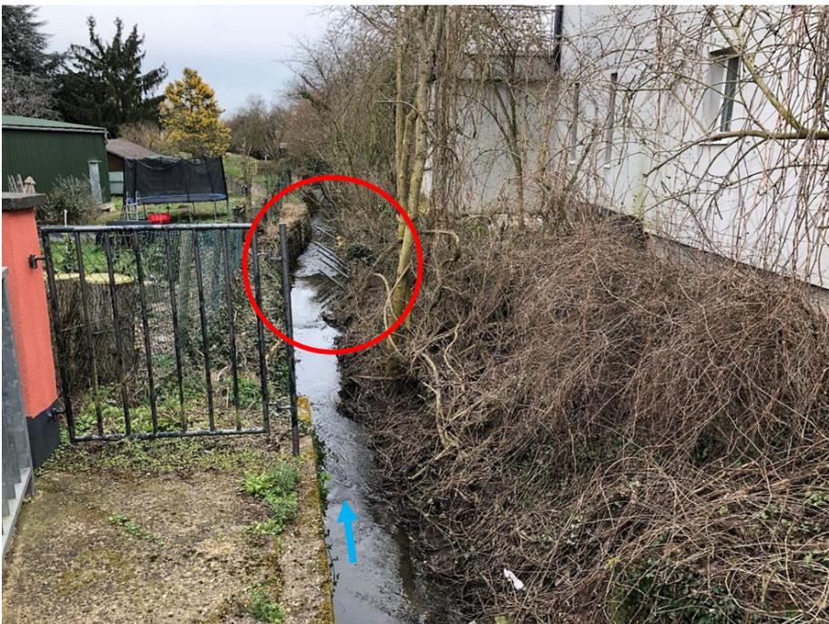
Abb. 76: Hainbach unterhalb der Bahnhofstraße mit gefährlicher Uferrutschung
