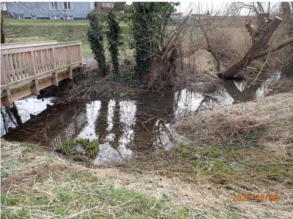
Abb. 39: Beschädigte Hochwasserentlastungsmulde des Hochwasserrückhaltebeckens
