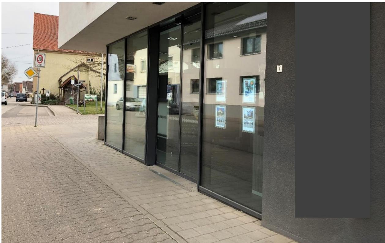
Abb. 10: Beispiel für überflutungsfördernde Bauweise (ebenerdige Türen bei niveaugleichem Straßenausbau)
