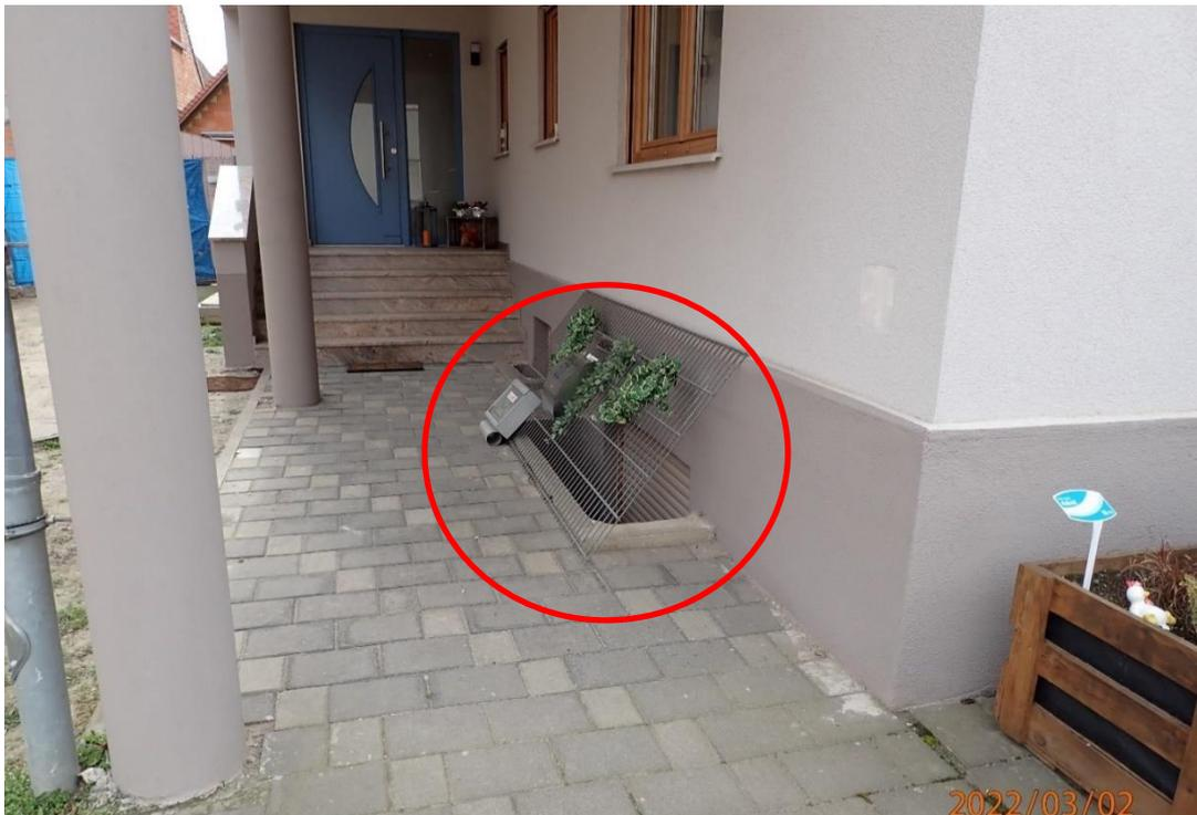
Abb. 11: Beispiele für überflutungsgefährdete Untergeschosse
