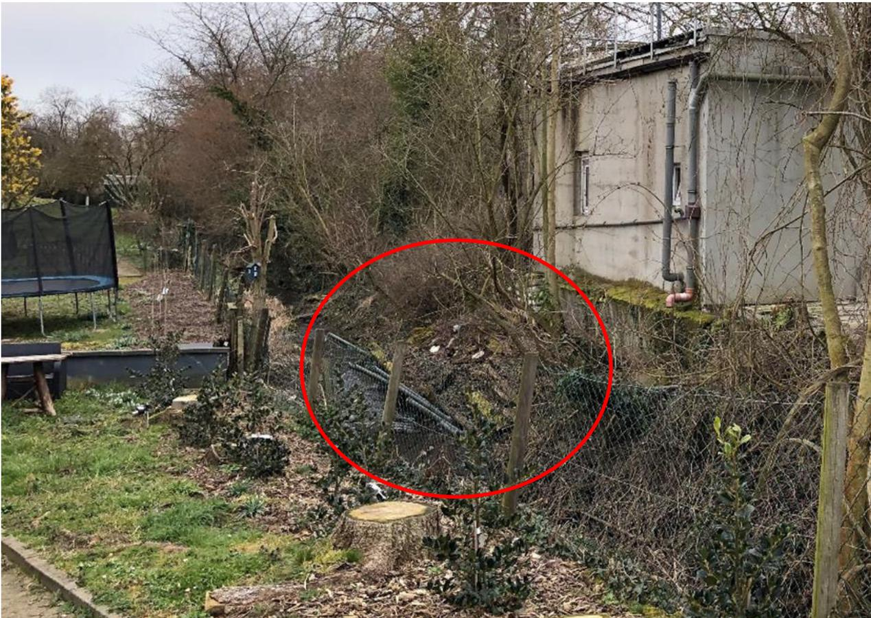
*Abb. 77: Gefährliche Ufersicherung und einsturzgefährdeter Anbau unterhalb der Bahnhofstraße*
