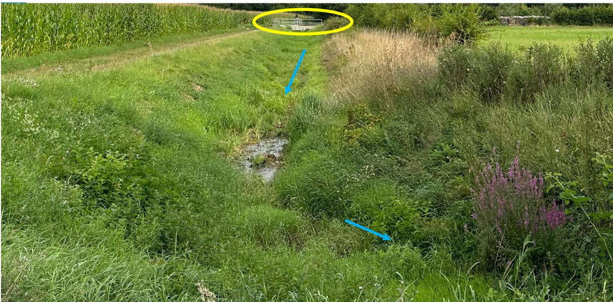
Abb. 25: Bypass-Graben mit Richtungswechsel, gelb: Trennbauwerk Lustadt
