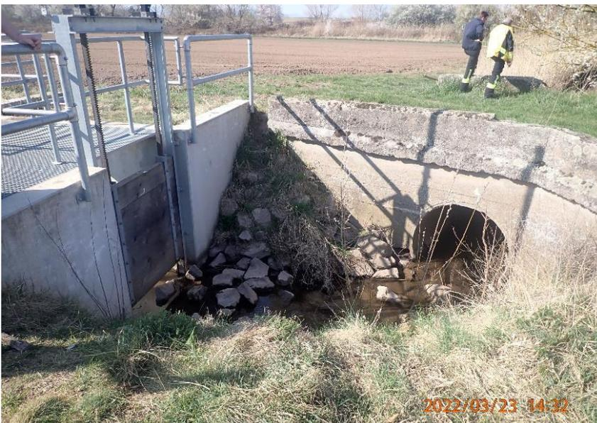
Abb. 6: Trennbauwerk zum Hochwasserschutz von Lustadt
