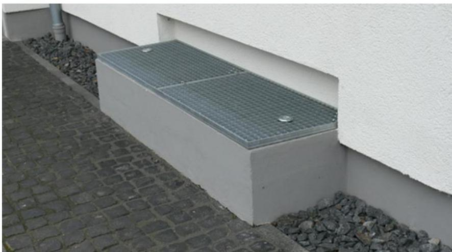
Abb. 15: Beispiele für die Sicherung von niveaugleichen Lichtschächten
