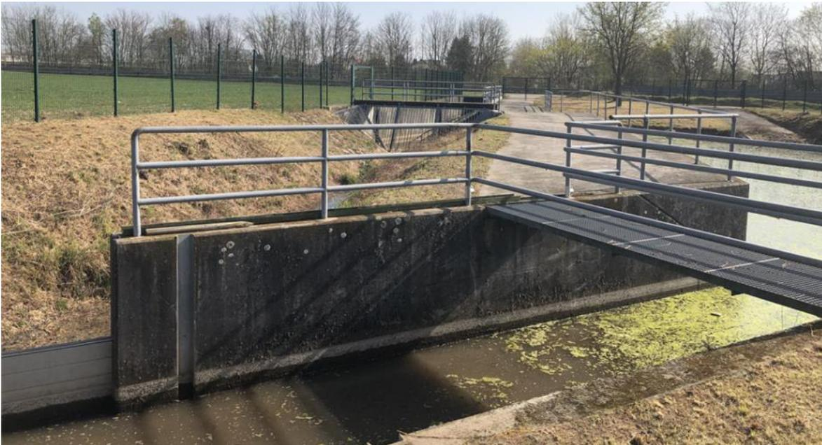
Abb. 49: Zulauf zum Absetzbecken (vorne) und Hochwasserabflusskanal mit großem Rechen (links)
