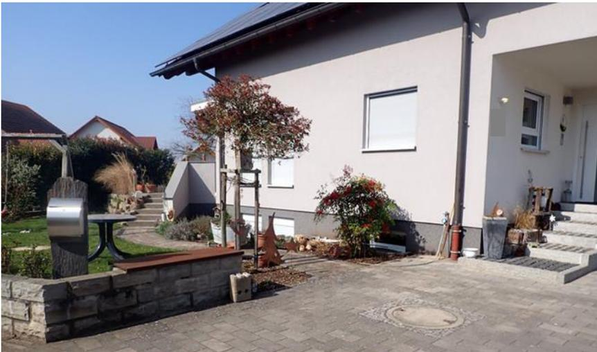
Abb. 14: Beispiel für überflutungsfördernde Bauweise durch abschüssige Garagenzufahrt bzw. Untergeschoss
