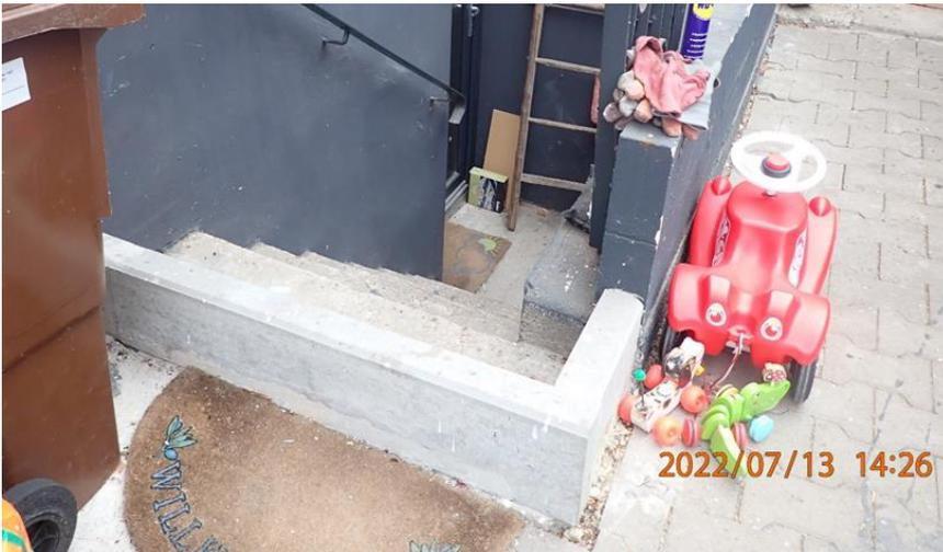
Abb. 16: Beispiel für die Sicherung eines außenliegenden Kellerzugangs
