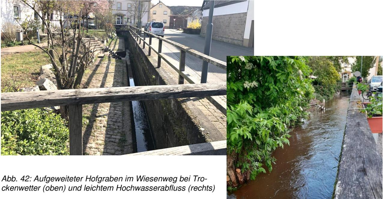
*Abb. 42: Aufgeweiteter Hofgraben im Wiesenweg bei Trockenwetter (oben) und leichtem Hochwasserabfluss (rechts)*
