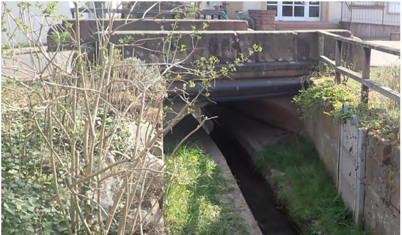
*Abb. 43: Engstelle Brücke Raiffeisenstraße und unzulässiges Schott zur Notentlastung*
