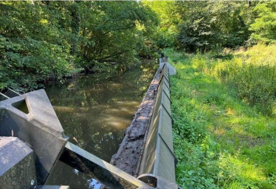
Abb. 7: Wehr am Abschlag von Hochwasser aus der Queich in den Flutgraben zur Druslach
