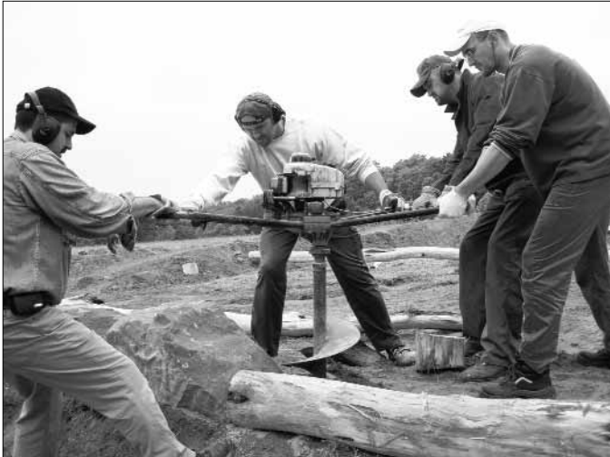
Marcus Heinzmann sowie die Brüder Paul, Waldemar und Alexander Barz waren - wie hier beim Bohren von Löchern für Stützpfosten - fast immer auf der „Baustelle“ aktiv.
