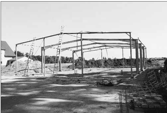
Baustelle am 19. August 2009
